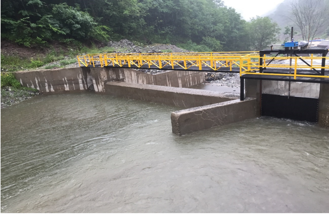
Şəkil 3 Ağbulaq KSES-in baş qurğusu
