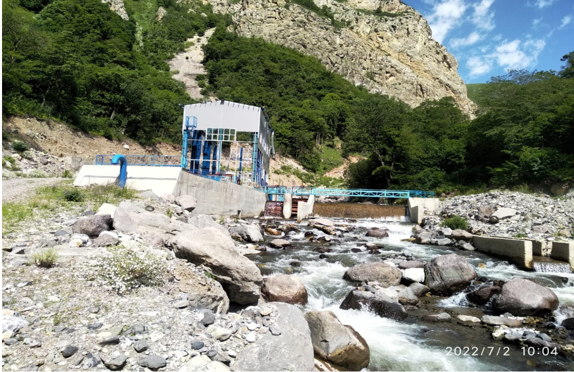
Şəkil 5 Ağbulaq KSES - in binası
