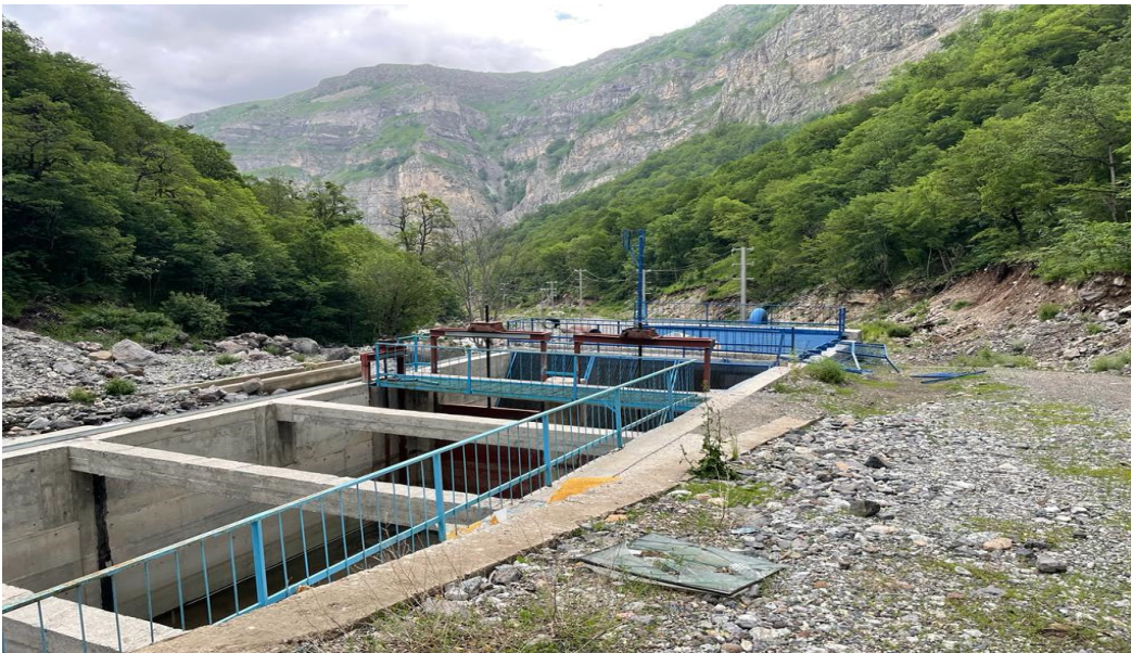
Şəkil 4 Ağbulaq KSES - in basqılı hovuz
